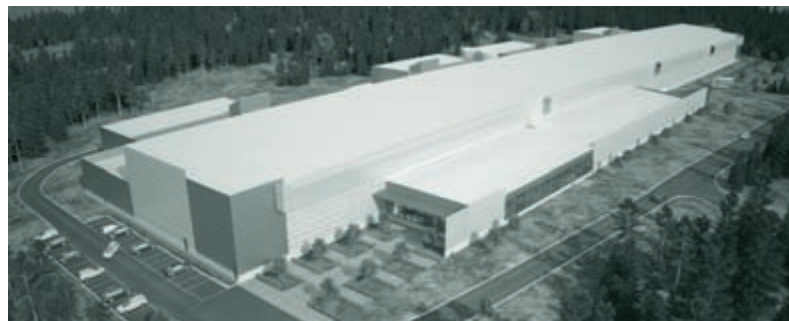
Facebook datacenter i Luleå kommer att bestå av tre serverhallar på totalt 84 000 kvadratmeter. Den första delen av den första hallen blev klar i januari.
